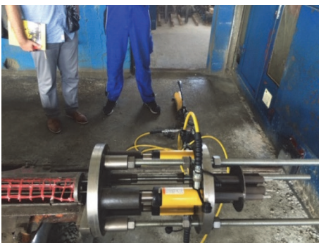
Slika 6. Armaturni koš od CFRP pripremljen za prednapinjanje
