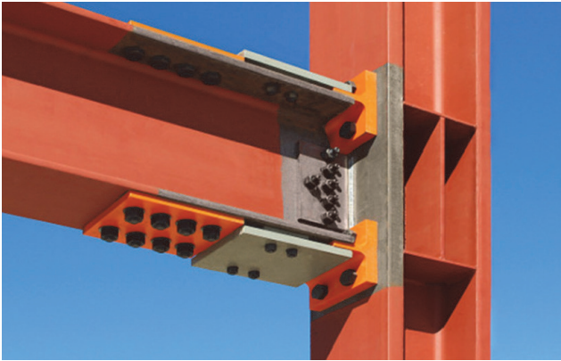
Slika 4. Priključak nosač-stup s popustljivom vezom [17]
