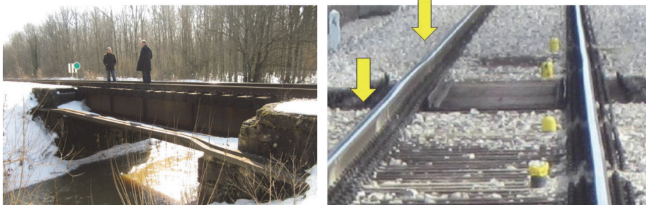
Slika 2. Prikaz mosta "Buna" (lijevo) te vidljiva deformacija geometrije kolosijeka (desno)
