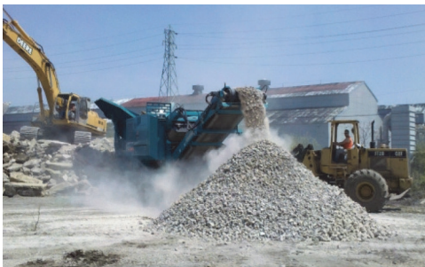
Slika 6. Reciklažno pokretno postrojenje [5]
