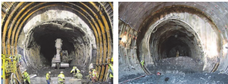
Slika 1. Redukcija poprečnog presjeka uzrokovana gnječenjem stijenske mase u okolini otvora željeznikog tunela Lyon-Torino, [2]
