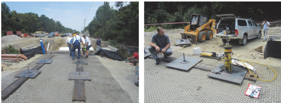
Slika 6. Izvođenje GRS sloja (prednapeti geosintetici)
