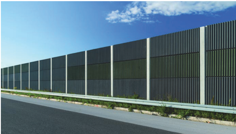
Slika 2. Ruconbar apsorbirajuća barijera za zaštitu od buke na autocesti Zagreb-Sisak
