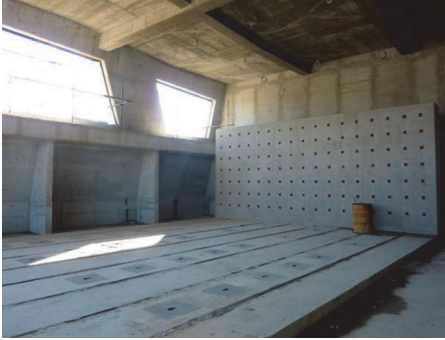
Slika 3. Laboratorij u novoj zgradi Građevinskog fakulteta u Osijeku s prikazom reaktivne ploče i reaktivnog zida
