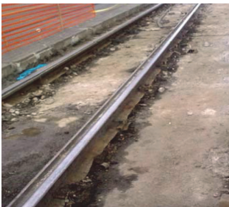
Slika 3. Stanje kolosijeka prije demontaže, Ilica, 2012. godina [15]
