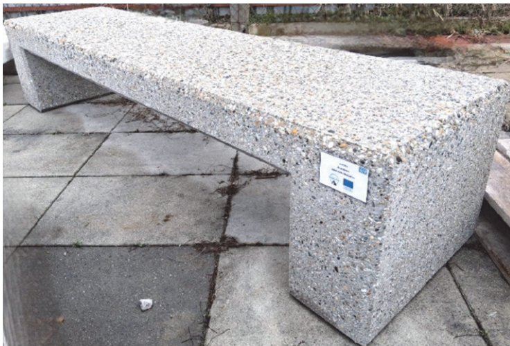
Slika 3. Predgotovljena betonska klupa proizvedena s miješanim cementom sa 16 % PDB-a
