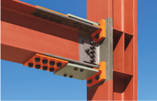
Slika 4. Priključak nosač-stup s popustljivom vezom [17]
