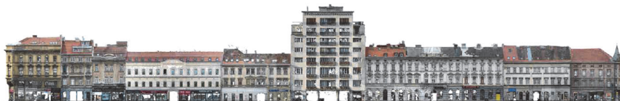
Slika 6. Ilica: prikaz pročelja zgrada u nizu Bloka 19 [2]
