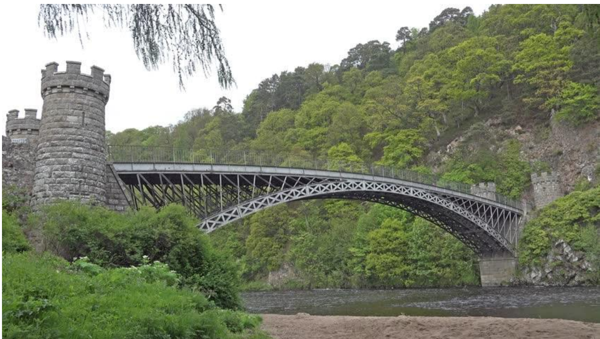
Slika 10. Most prijeko rijeke Spey u Škotskoj, 1813. g. Prvi moderni metalni most
