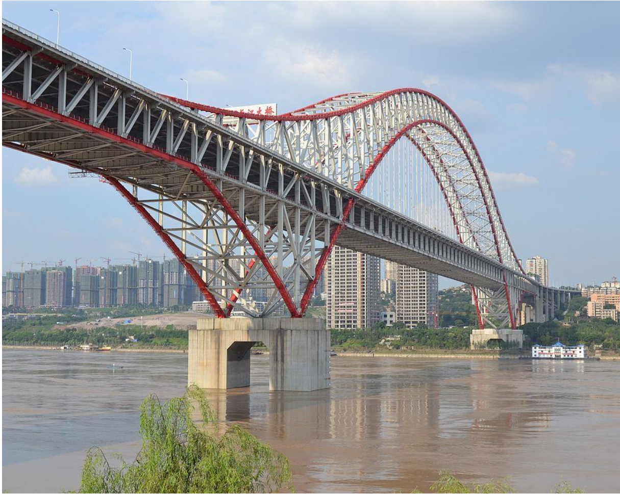
Slika 11. Most Chaotianmen, Chongqing, Kina, lučni most najvećeg raspona na svijetu (552 m)
