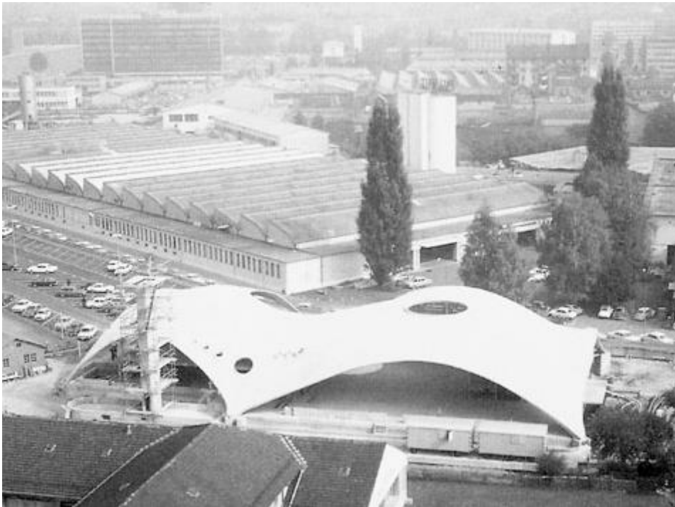
Slika 26.: Islerova zgrada tvornice Sicli u Ženevi (Izvor: [31])
