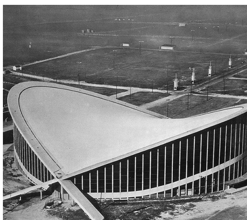
Slika 3. Antiklastičan oblik krovne konstrukcije kablova ovješениh u pretenaste grede
