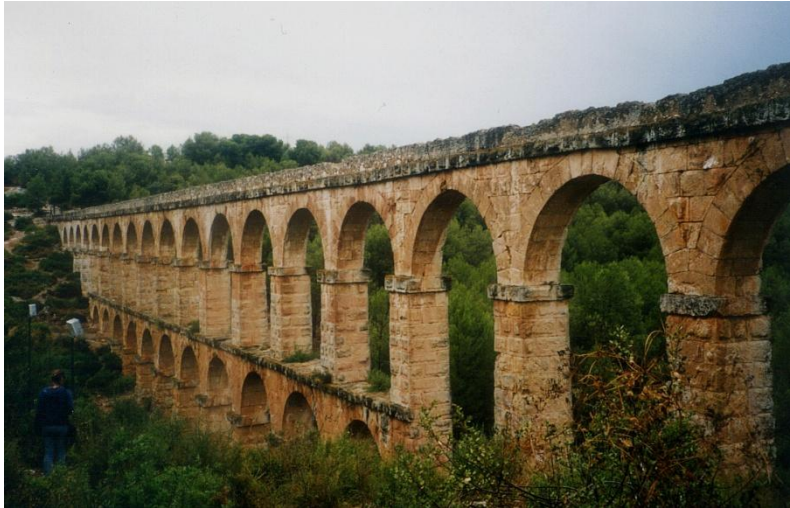
Slika 5. Pont de les Ferreres
