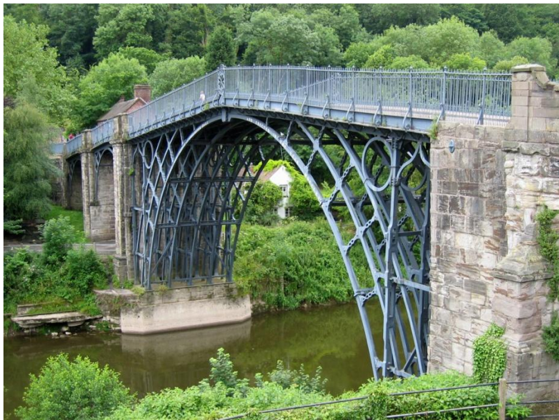
Slika 7. Prvi metalni lučni most preko rijeke Severn
